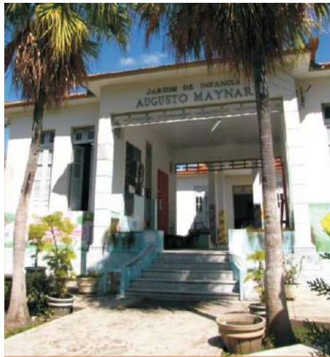
Figuras 79 – Fachada do monumento - Endereço: Rua Dom José Thomaz, 106.
