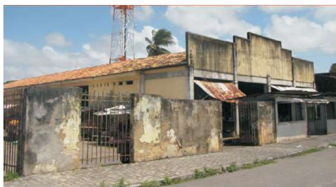
Figura: 78 – Fachada da edificação - Endereço: Rua Carlos Correia, s/nº.
