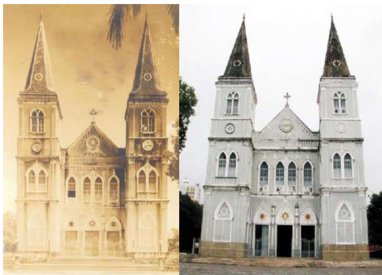
Figura 11 e 12 – Fachada em período distintos - Endereço: Praça Olímpio Campos, s/nº.
