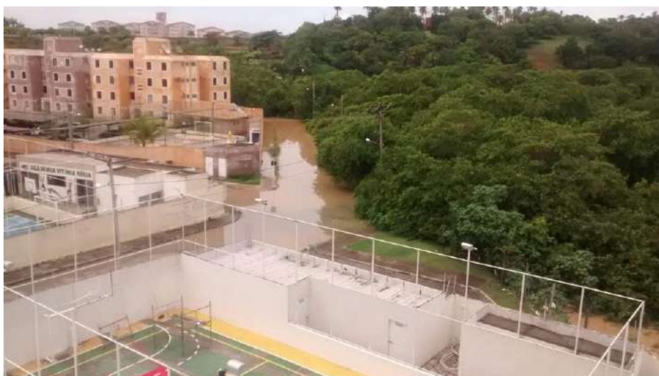
Figura VIII.6: Pontos de alagamentos próximos a empreendimentos localizados em áreas de fragilidade ambiental, Bairro Jabotiana, Maio de 2015.
