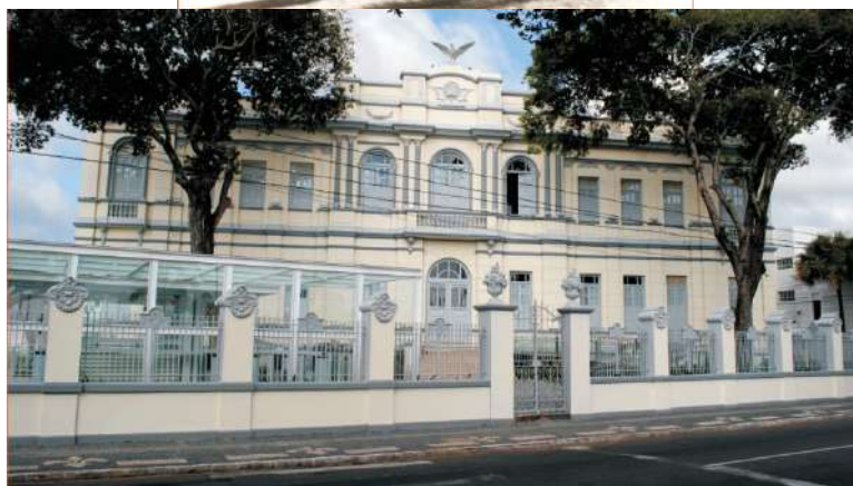
Figura 3 e 4 - Fachada antes e depois - Endereço: Av. Ivo do Prado, 398.
