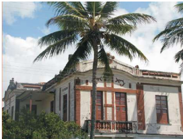
Figura 71 – Fachada do monumento - Endereço: Av. General Calazans, 586.
