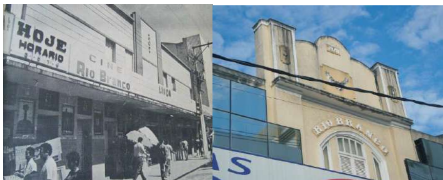
Figura 69 e 70 - Fachada em períodos distintos - Endereço: Rua João Pessoa, 182.
