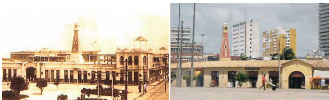
Figuras 82 e 83 – Fachadas em períodos distintos - Endereço: Rua José do Prado Franco, s/nº.
