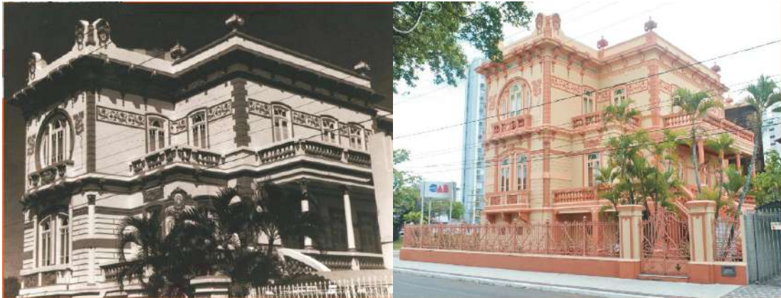
Figuras 21e 22 – Fachada em períodos distintos - Endereço: Av. Ivo do Prado, 1072.
