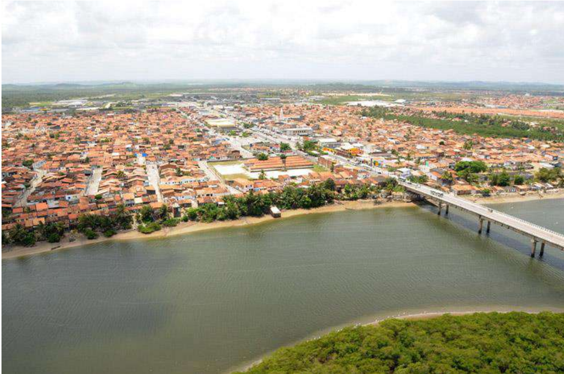
FIGURA IX.21: Ponte sobre o Rio do Sal- Bairro Porto D´Antas (Aracaju) / Conjunto Marcos Freire II (Nossa Senhora Do Socorro). Fonte: http://www.socorro.se.gov.br
