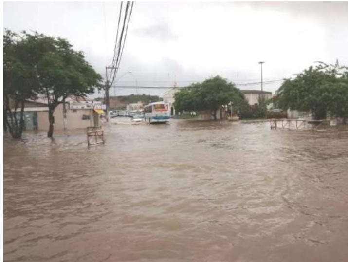
Figura VI.4: Ponto de alagamento crítico do bairro Jabotiana, conjunto Santa Lúcia, Maio de 2015.
