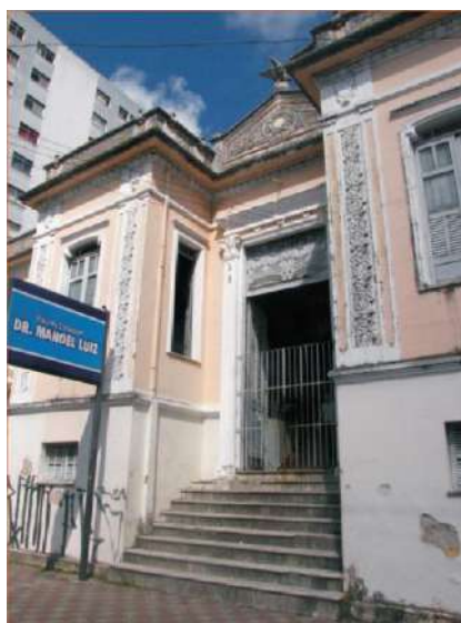
Figura 90: Fachada do monumento - Endereço: Av. Pedro Calazans, 1184.
