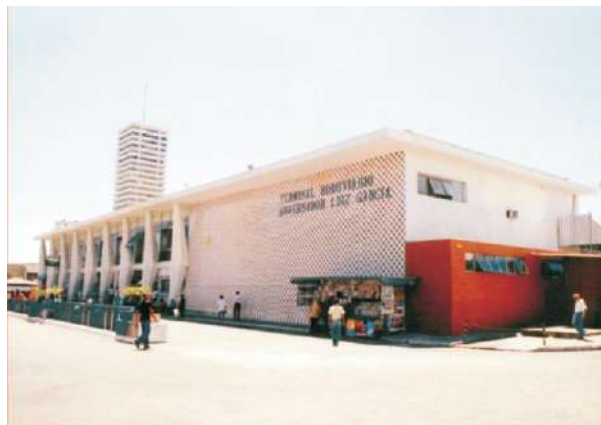
Figura 52 – Fachada recente – Endereço: Praça João XXIII
