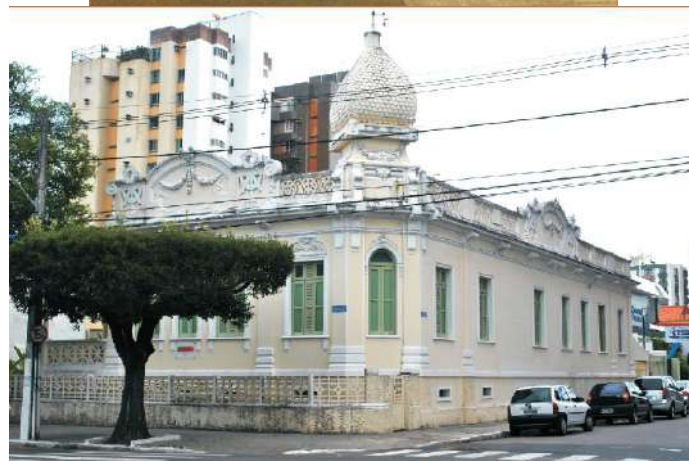
Figuras 35 e 36 – Fachadas em períodos distintos - Endereço: Av. Barão de Maruim, 225.
