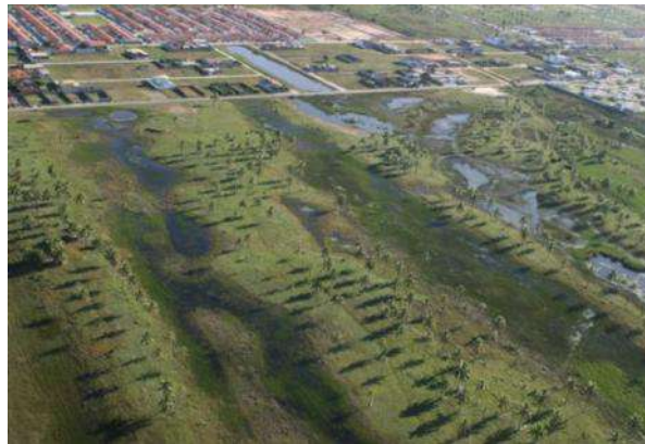
Figura X.14: Vazios urbanos e lagoas de drenagem. Fonte: PMA, 2008
