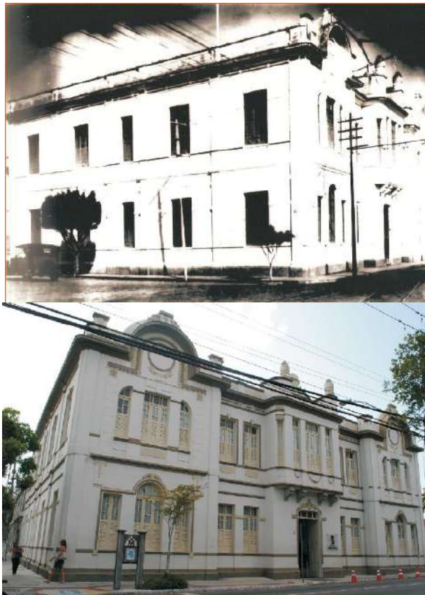
Figura 5 e 6 – Fachada antes e depois - Endereço: Praça Olímpio Campos, s/nº.
