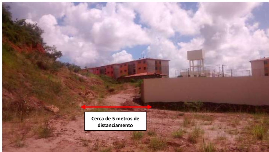
Figura VIII.5: Proximidade de empreendimentos a áreas de várzeas do rio, Bairro Jabotiana. Fonte: Trabalho de campo realizado em junho de 2015.
