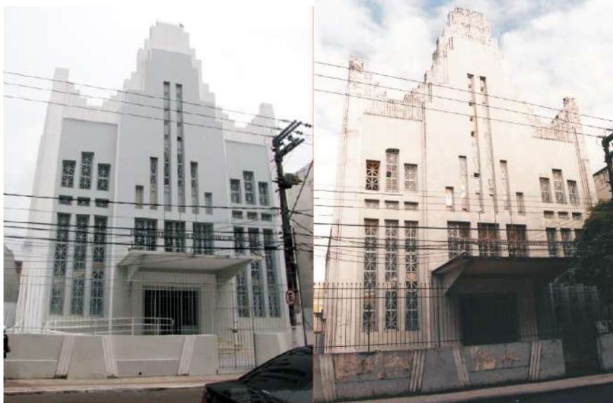
Figuras 47 e 48 – Fachada em períodos próximos - Endereço: Rua Itabaianinha, nº 41.
