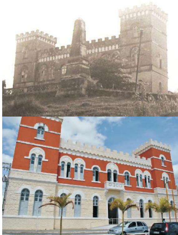
Figuras 41 e 42 – Fachadas antes e depois - Endereço: Rua José Zuckman, s/nº, Bairro América.
