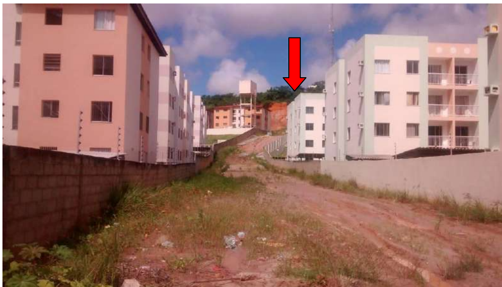
Figura VIII.4: Proximidade de empreendimentos a áreas de risco de deslizamento, área de morro no bairro Jabotiana, área classificada com alto risco de deslizamento. Fonte: Trabalho de campo realizado em junho de 2015.
