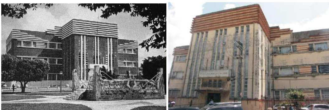
Figuras: 74 e 75- Fachadas em períodos distintos - Endereço: Praça General Valadão, s/nº.
