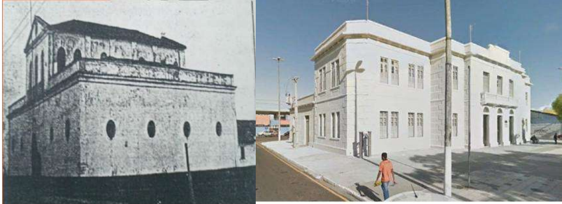
Figuras 33 e 34 – Fachadas em épocas distintas - Endereço: Praça General Valadão, nº 134.
