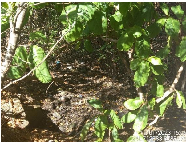
Foto 2-161 - Saída de drenagem identificada
