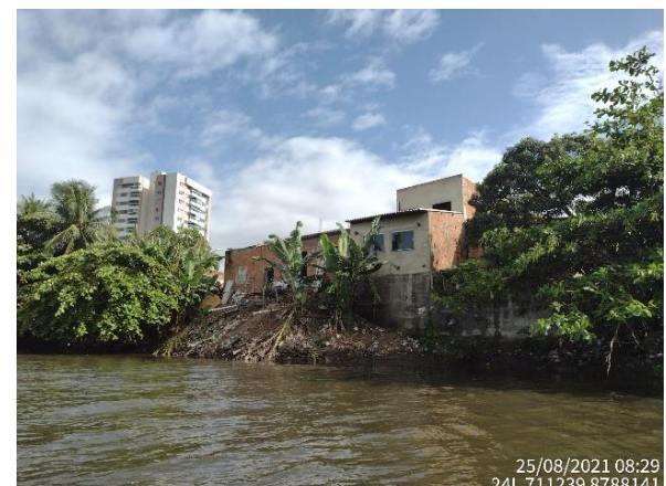
Foto 2-109: Construções na margem do rio Poxim.
