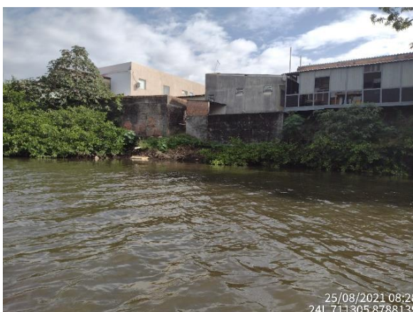
Foto 2-108: Construções na margem do rio Poxim.
