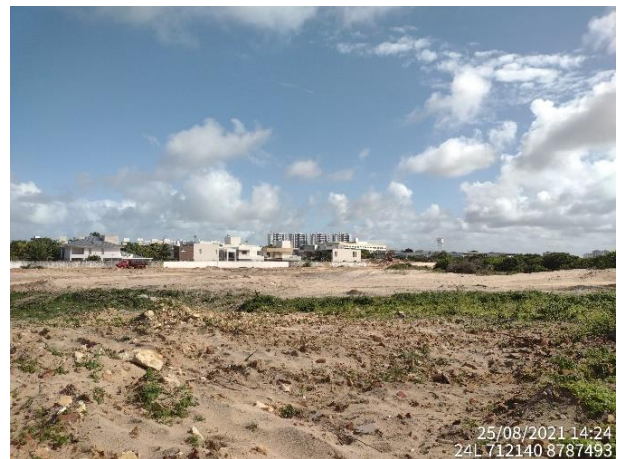
Foto 2-146 – Trecho 11: Área do loteamento em construção nos limites da UC
