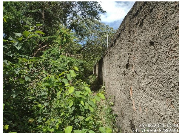
Foto 2-123 – Trecho 2: Muro de Conjunto Habitacional delimitando o limite da UC
