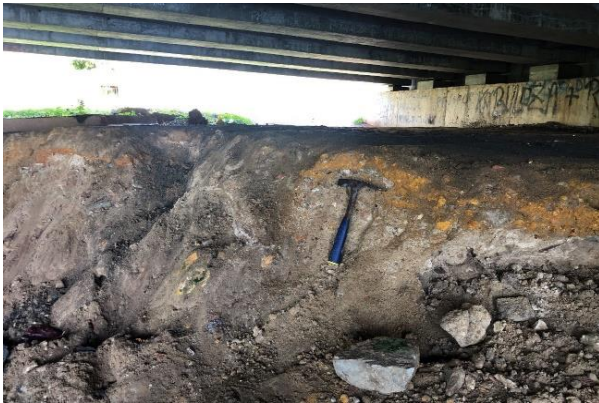
Foto 2-7 – Depósito Tecnogênico para construção de estrutura urbana (ponte) - Coordenadas UTM - 24L - 711.006 mE, 8.788.112 mN
