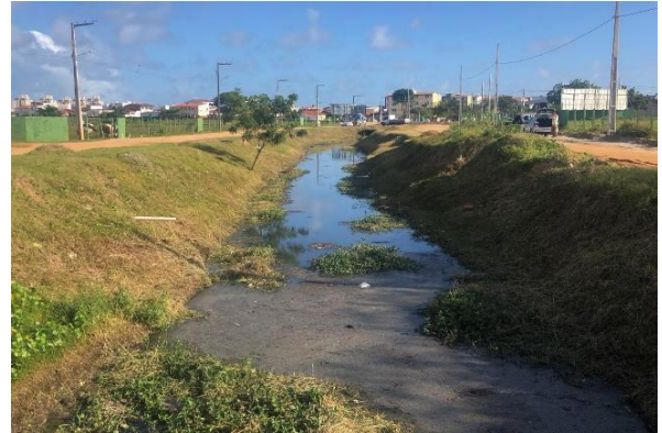
Foto 2-16 - Retificação de canal e mudanças na morfologia original - Coordenadas UTM – 24S - 711.492 mE, 8.787.211 mN
