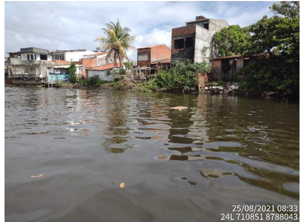
Foto 2-111: Construções na margem do rio Poxim.
