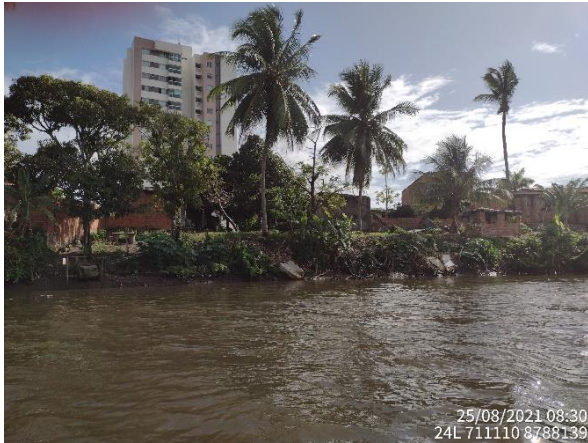
Foto 2-110: Construções na margem do rio Poxim.
