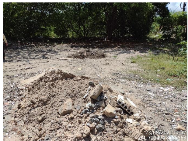
Foto 2-135 – Trecho 6: Resto de resíduos de demolição.
