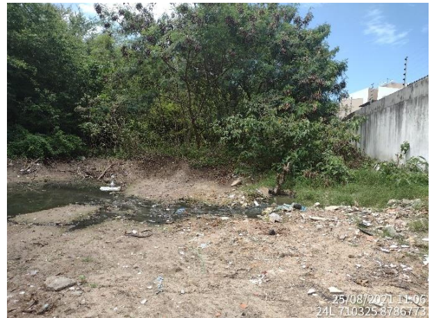
Foto 2-129 – Trecho 5: Lançamento irregular de efluentes
