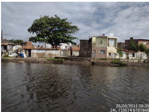
Foto 2-112: Construções na margem do rio Poxim.
