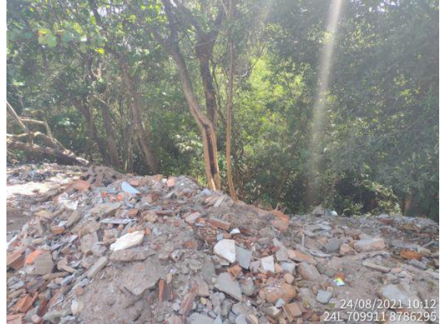
Foto 2-125 – Trecho 3: presença de resíduos sólidos de construção civil.
