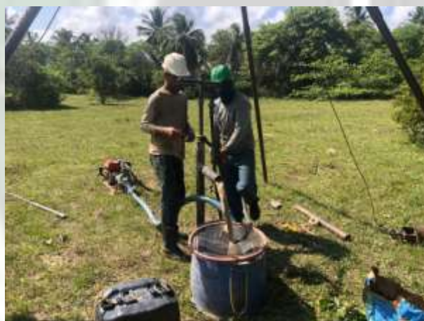
Foto 16 EXECUÇÃO DE SONDAGEM À PERCUSSÃO (SPT).
