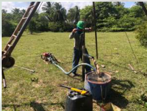
Foto 08 EXECUÇÃO DE SONDAGEM À PERCUSSÃO (SPT).
