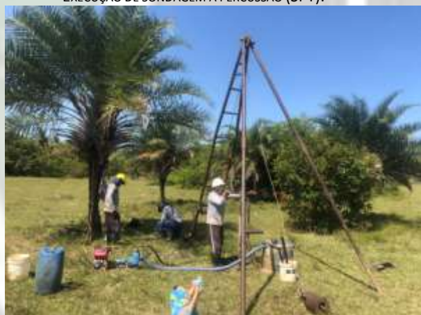
Foto 04 EXECUÇÃO DE SONDAAGEM À PERCUSSÃO (SPT).
