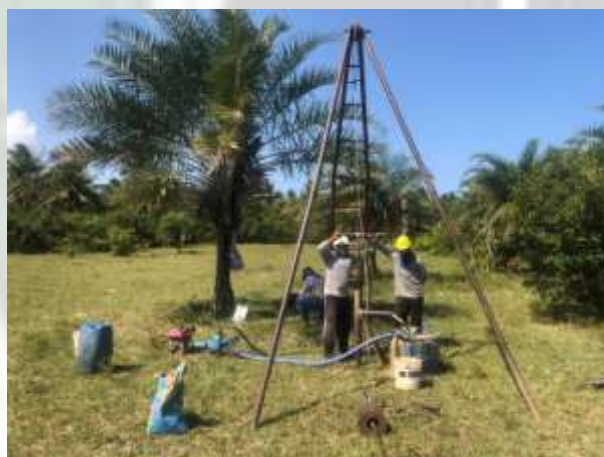
Foto 10 EXECUÇÃO DE SONDAGEM À PERCUSSÃO (SPT).
