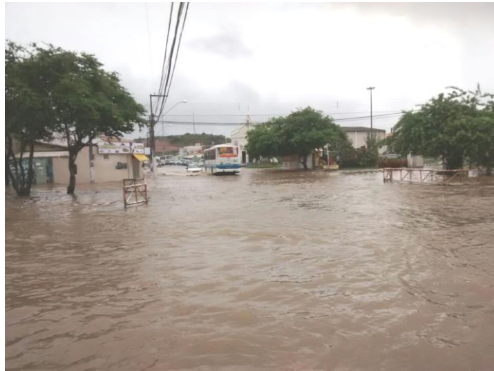
Figura VI.4: Ponto de alagamento crítico do bairro Jabotiana, conjunto Santa Lúcia, Maio de 2015.
